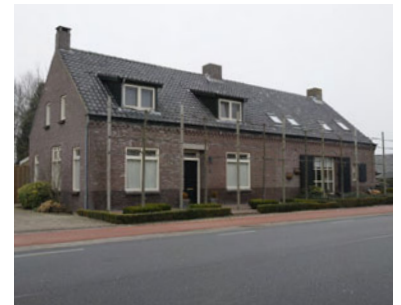
Bij verbouwing het onderscheid tussen de bouwdelen behouden
