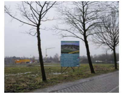
De Esrand is in aanbouw aan de noordzijde van Nederwetten
