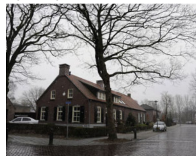
De lage doorgaande goot is belangrijk in de verschijningsvorm
