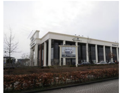
Een dubbele voorgevel bij de entree van het terrein
