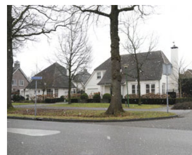
Individuele woningbouw aan de noordrand van het gebied
