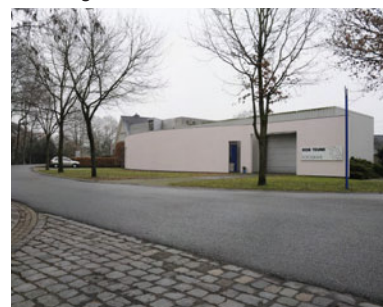
Reclame is ondergeschikt aan het hoofgebouw
